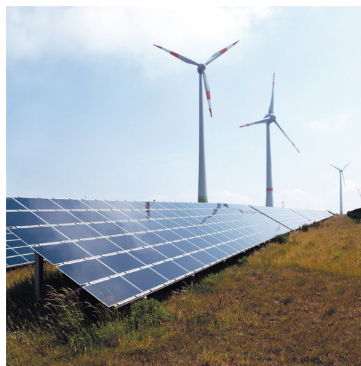
▲ Éoliennes et panneaux solaires à Schneebergerhof (Allemagne).
